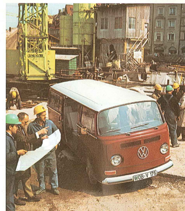
Pour aller du bureau au chantier et vice versa.
