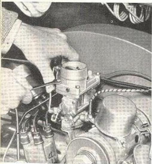
El montaje se efectúa a la inversa. Obsérvese el estado correcto y el buen asiento de la junta entre la parte superior e inferior y además, que el tubo de la bomba, que sobresale de la parte inferior, ajuste bien en la parte superior.
