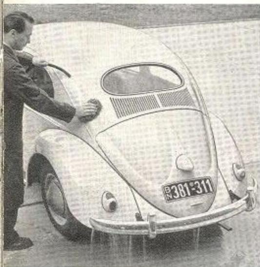
Las superficies barnizadas de la carrocería así como las ruedas se limpian a chorro suave y repartido hasta que el barro quede mojado. De ninguna manera debe aplicarse el chorro con toda intensidad sobre el barniz de la carrocería. Después se elimina el barro con la esponja y mucha agua de arriba hacia abajo, limpiando la esponja muy a menudo para evitar rascaduras en la parte pulida.
