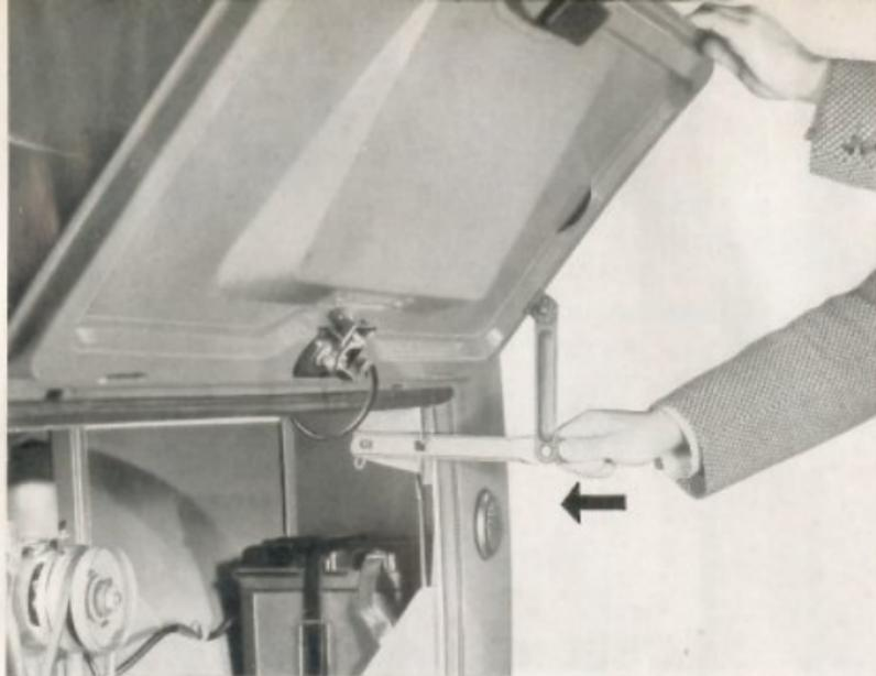
Bevor Sie die Prüfungen im Motorraum durchführen, öffnen Sie den Deckel mit dem beigegebenen Vierkantschlüssel. Der Deckel läßt sich wieder schließen, wenn die Haltevorrichtung durch einen Druck auf die waagrecht liegende Stange ausgelöst wird.
